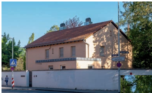
Noch steht das Pfarrhaus in der Webersgasse 21
